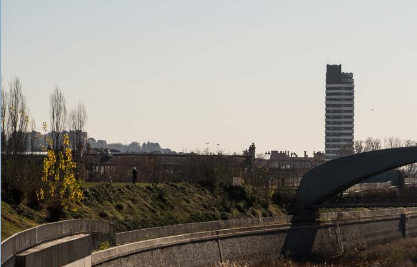
Perspectiva de los puentes gemelos del Invernadero y del Matadero (2010) que cuentan con sendas bóvedas de hormigón muy ligeras.
