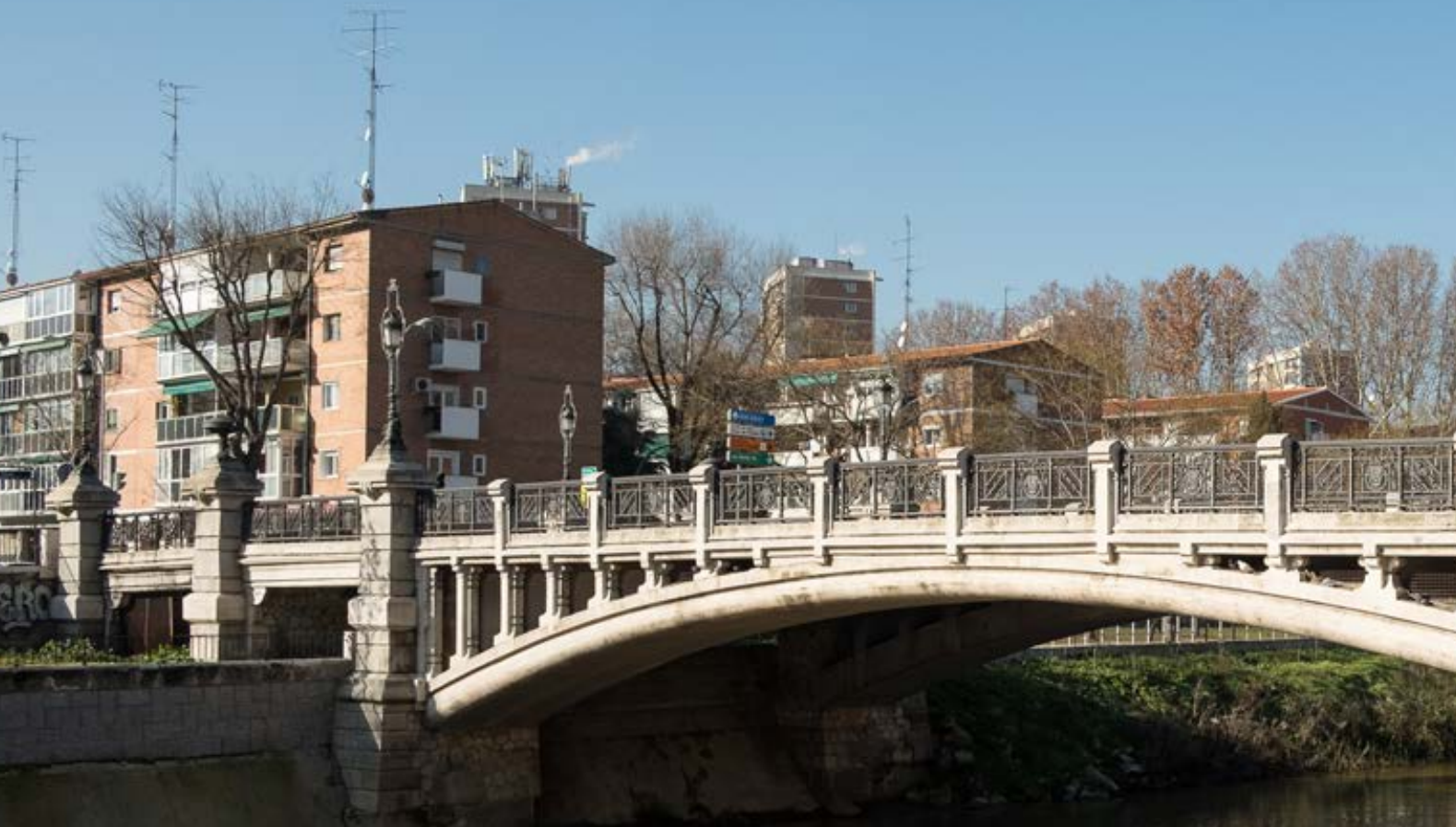
Puente de Reina Victoria (1909), una de las primeras construcciones de hormigón armado en España.
