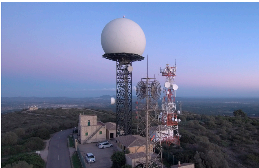
Radar en Mallorca.
