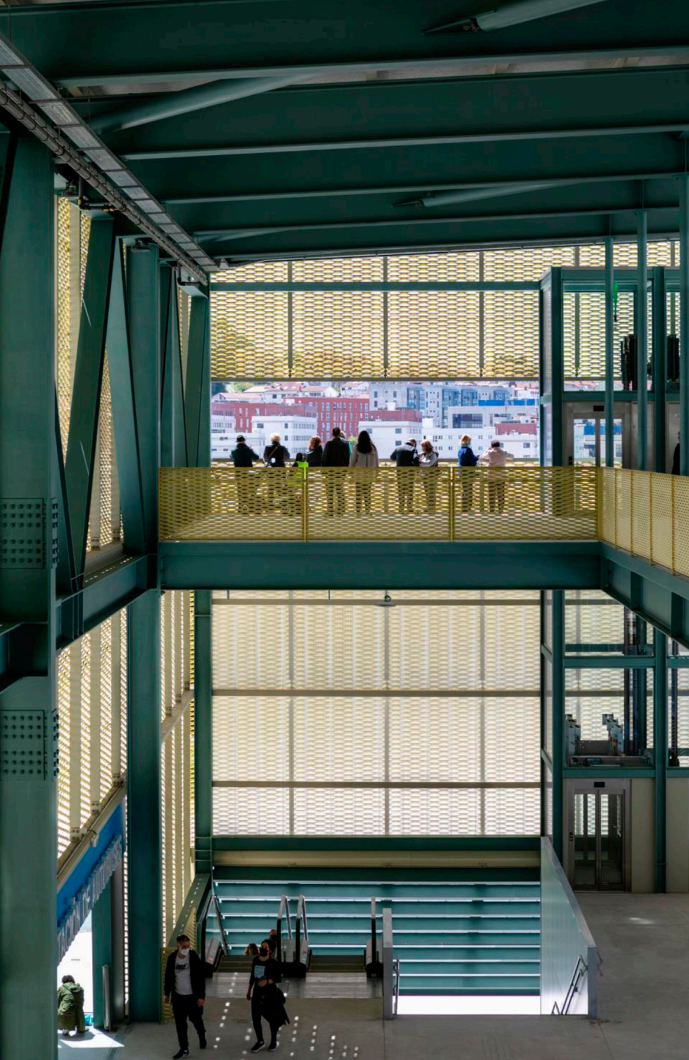
Vista de los niveles existentes en el lado norte de la pasarela.
