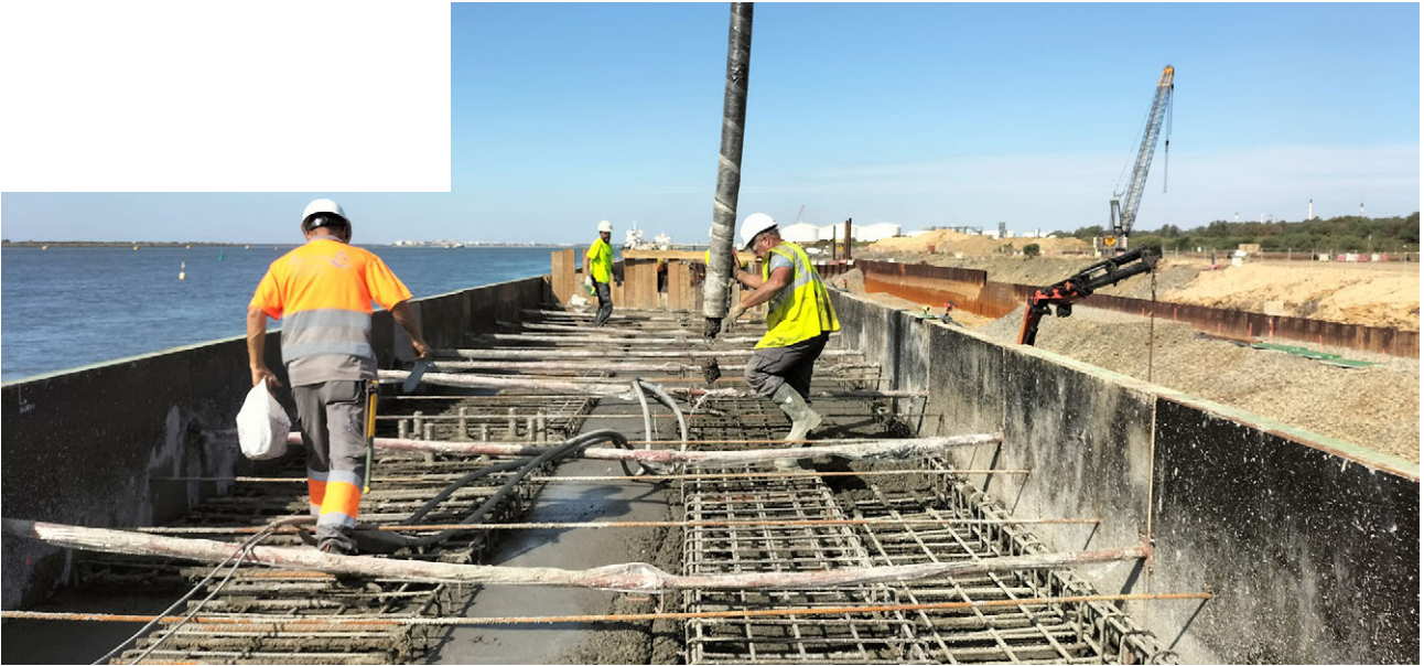
Hormigonado viga cantil.
