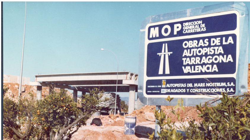
Ejemplo de señalización vertical.
