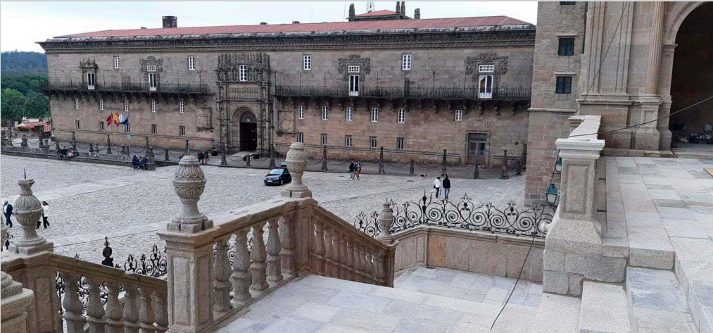
Plaza del Obradoiro. A la izquierda fachada principal de la Catedral y a la derecha fachada del Parador Nacional Hostal dos Reis Católicos.
