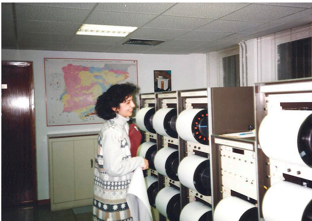
Personal de la RSN realizando las tareas de cambio de bandas en los registradores sísmicos en 1991.
