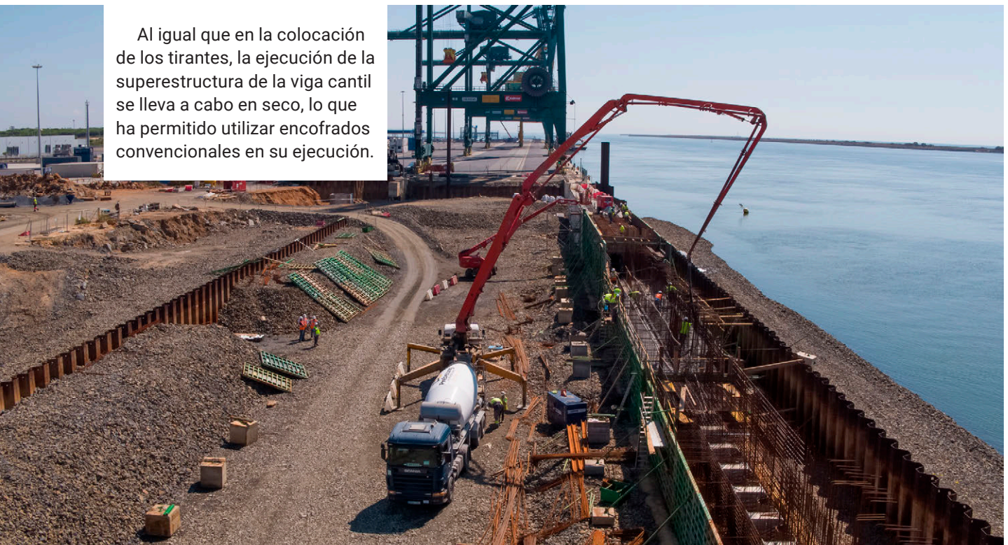
Construcción en seco de la viga cantil.
