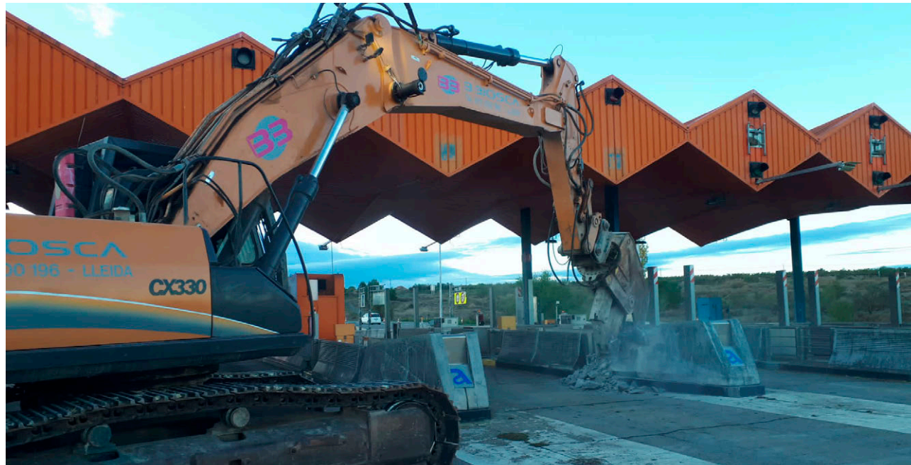
AP-2. Demolición marquesina peaje Lleida.
