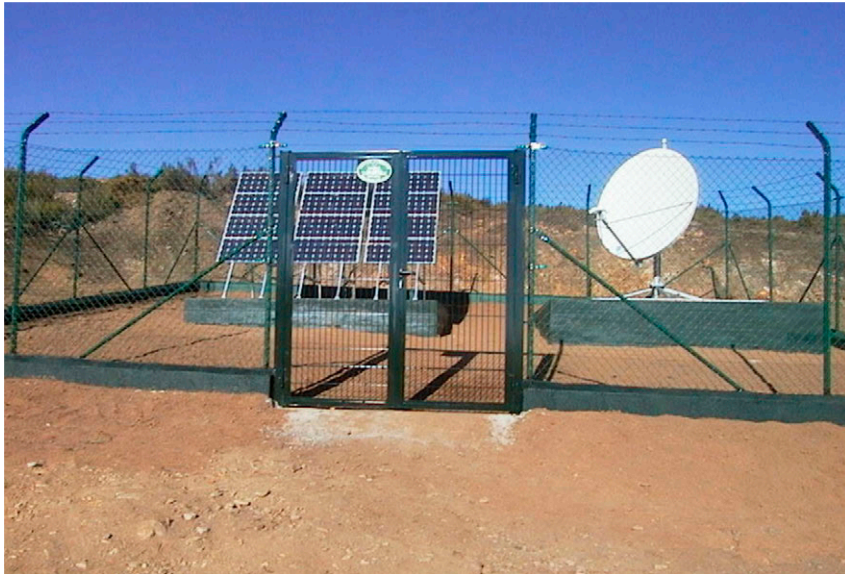
Estación sísmica en Zamora.
