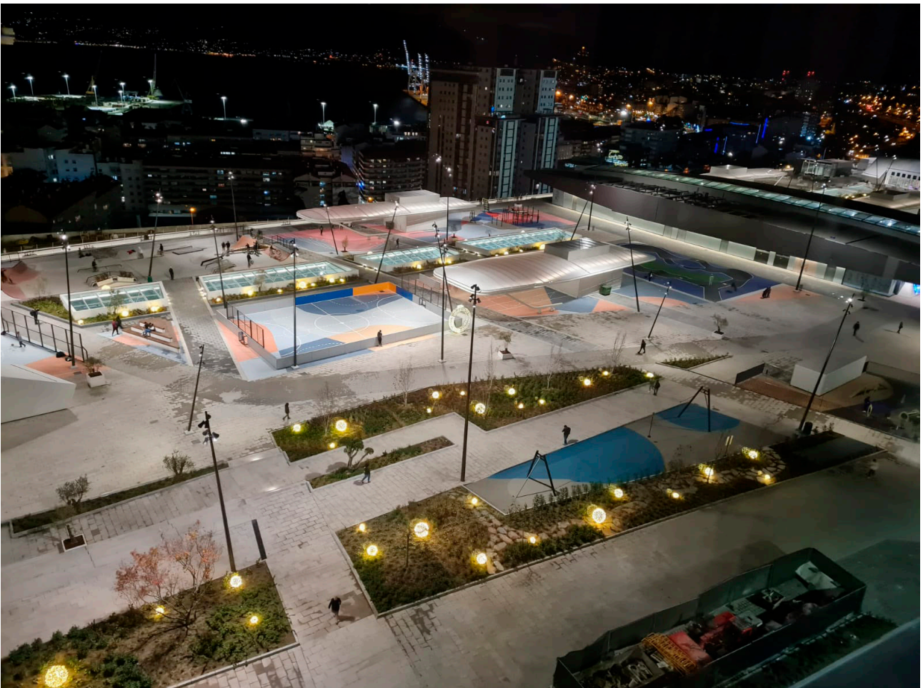
Plaza pública en la cubierta del edificio.
