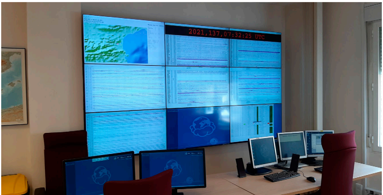
Sala de Alerta Sísmica.
