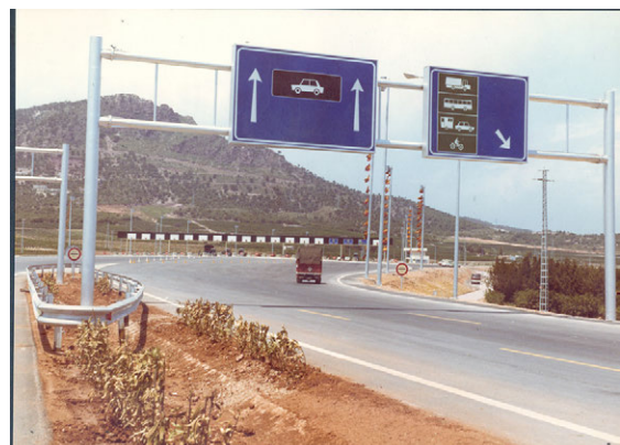
Ejemplo de señalización vertical.
