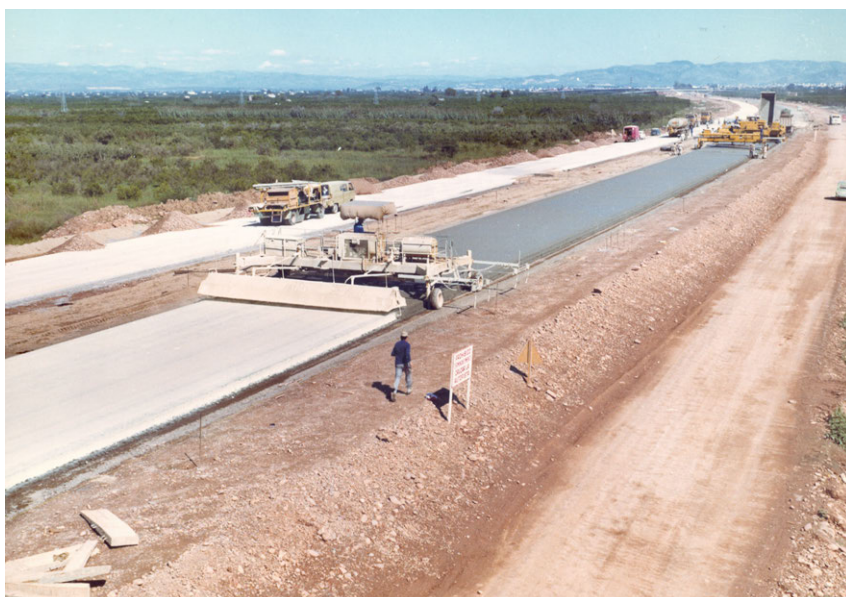
Tramo de autopista en construcción.
