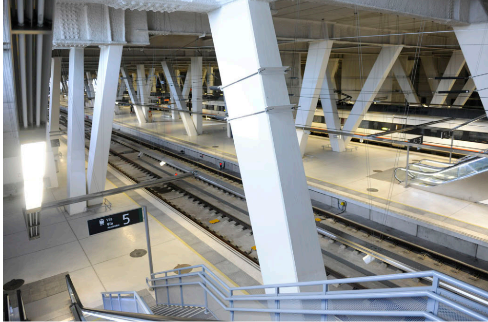
Andenes de la estación.
