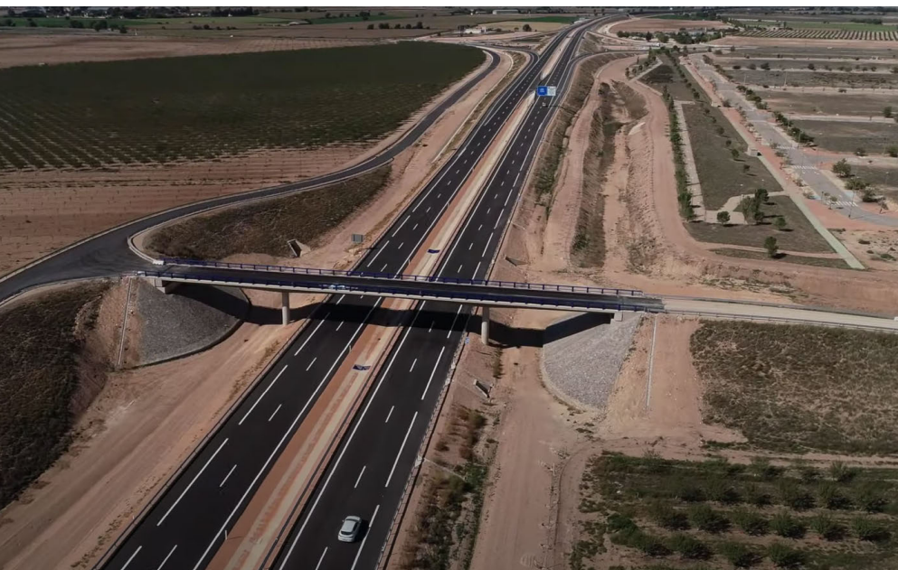
Vista del trazado de la nueva autovía cerca del enlace con la carretera CM-3203.
