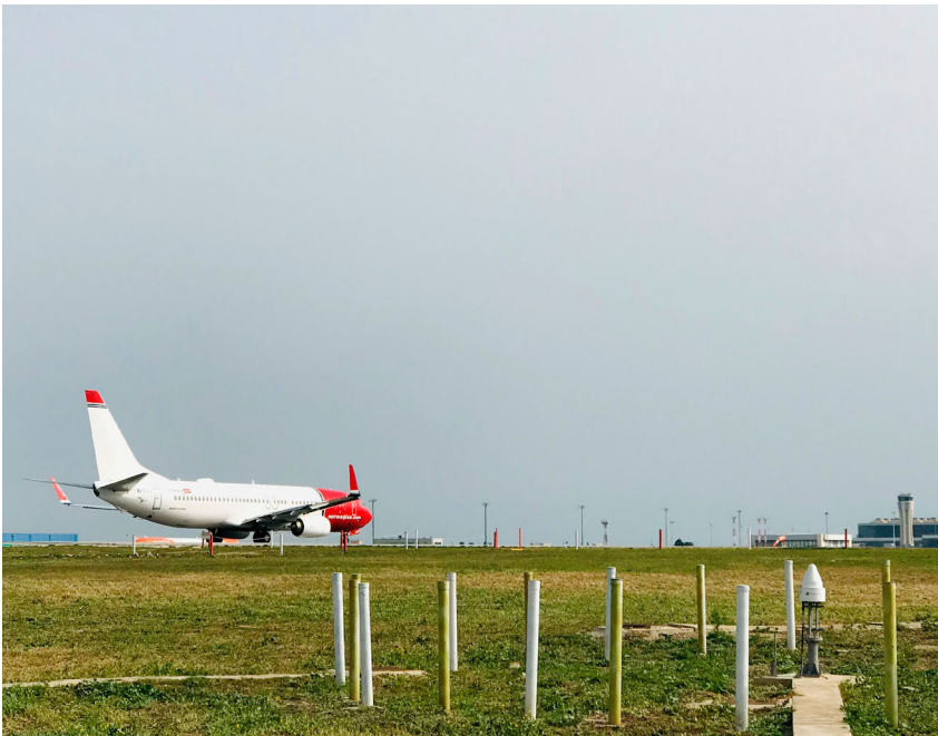
Antena GBAS en el Aeropuerto de Málaga-Costa del Sol.
