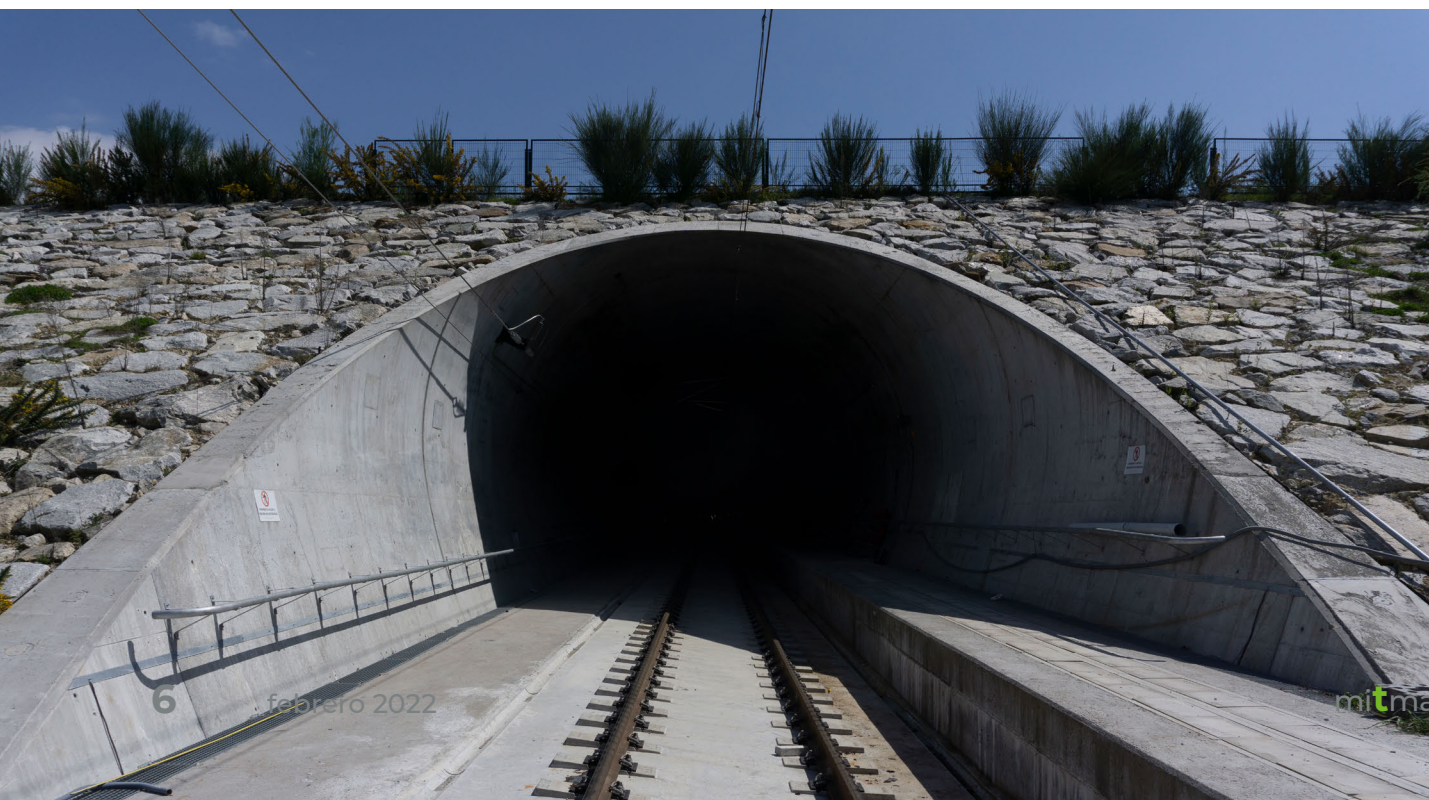
Boca del túnel de Prado vía derecha, de 7 606 m de longitud.
