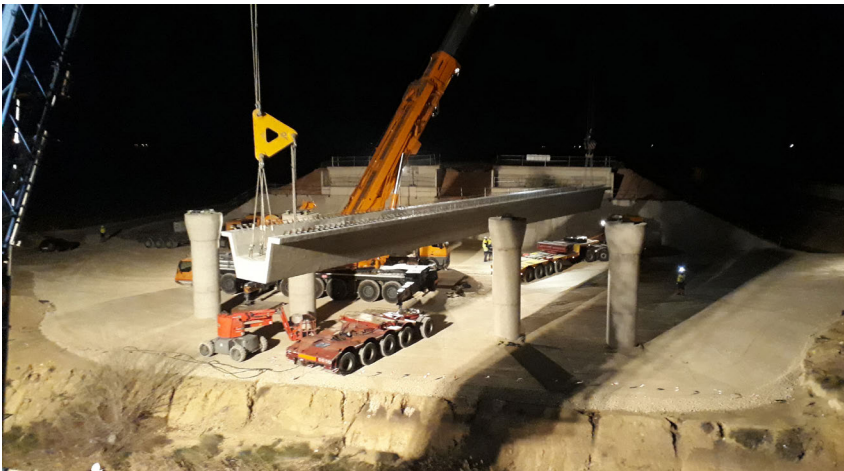
Trabajos de colocación de la viga de una estructura en horario nocturno.
