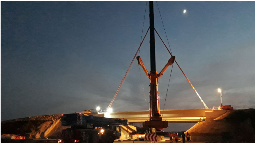
Colocación de la viga de una estructura en horario nocturno.
