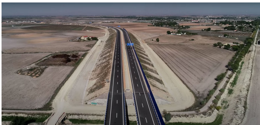
Prácticamente todo el trazado discurre elevado sobre un terraplén.
