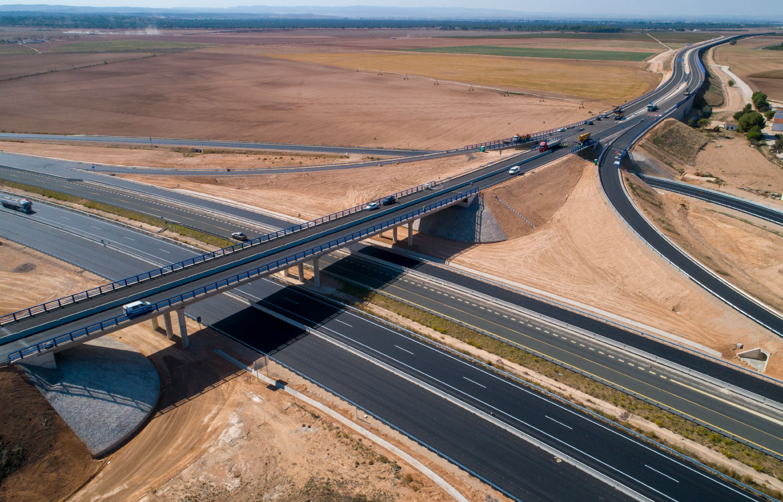
Nuevas vías colectoras y estructura en la autovía A-30, en su enlace con la Circunvalación en su enlace con la Circunvalación Sur.
