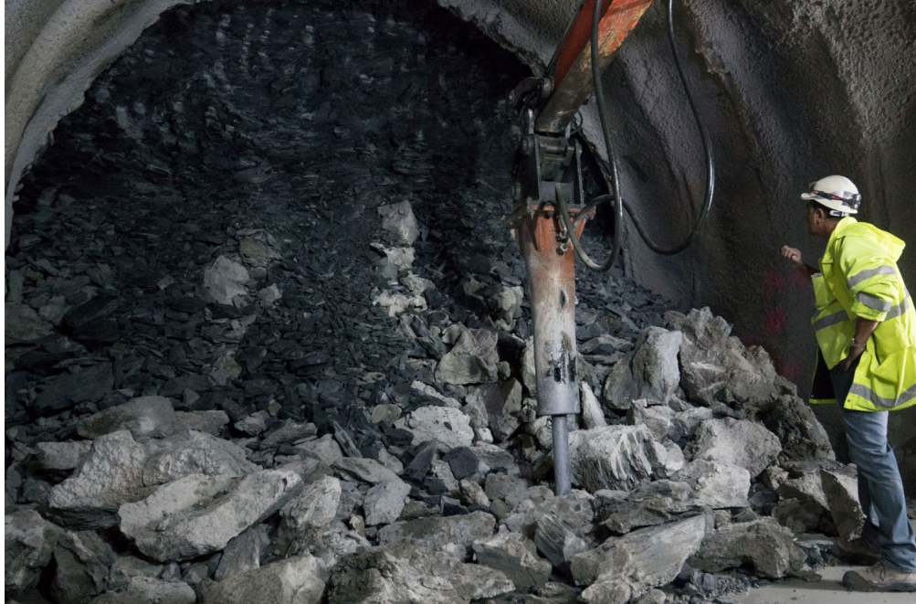
La gestión de los excedentes de material de los túneles ha sido uno de los desafíos de la obra.
