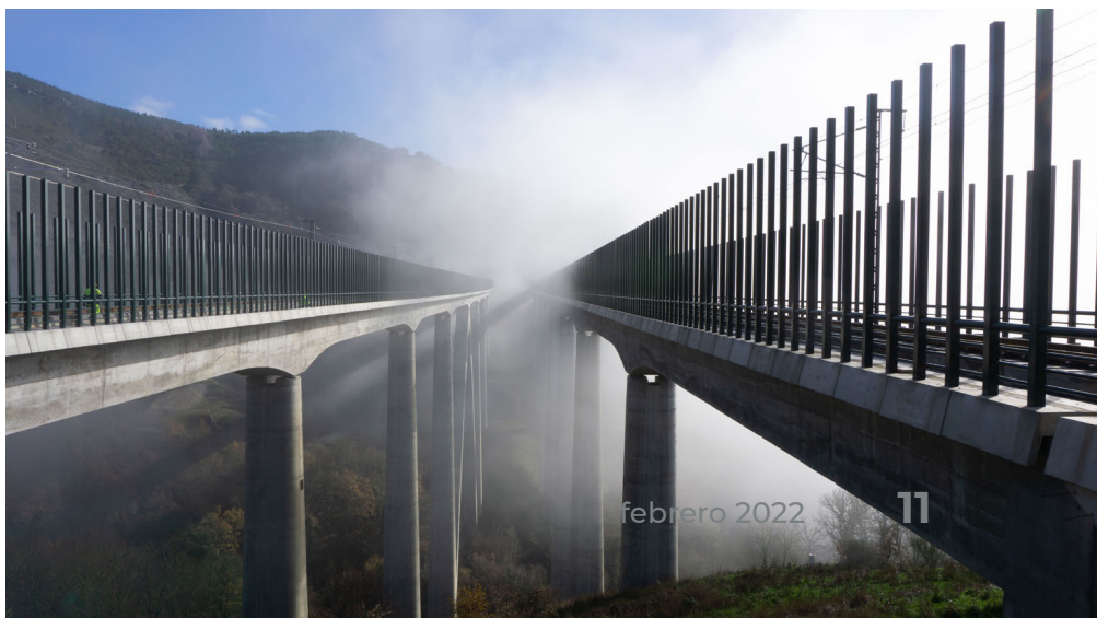
Vallas anticolidión de aves instaladas en los viaductos de Teixeira.
