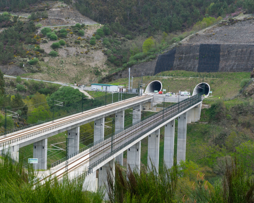
Bocas del túnel bitubo de O Corno, el más largo del tramo, y viaducto doble de Os Portos.
