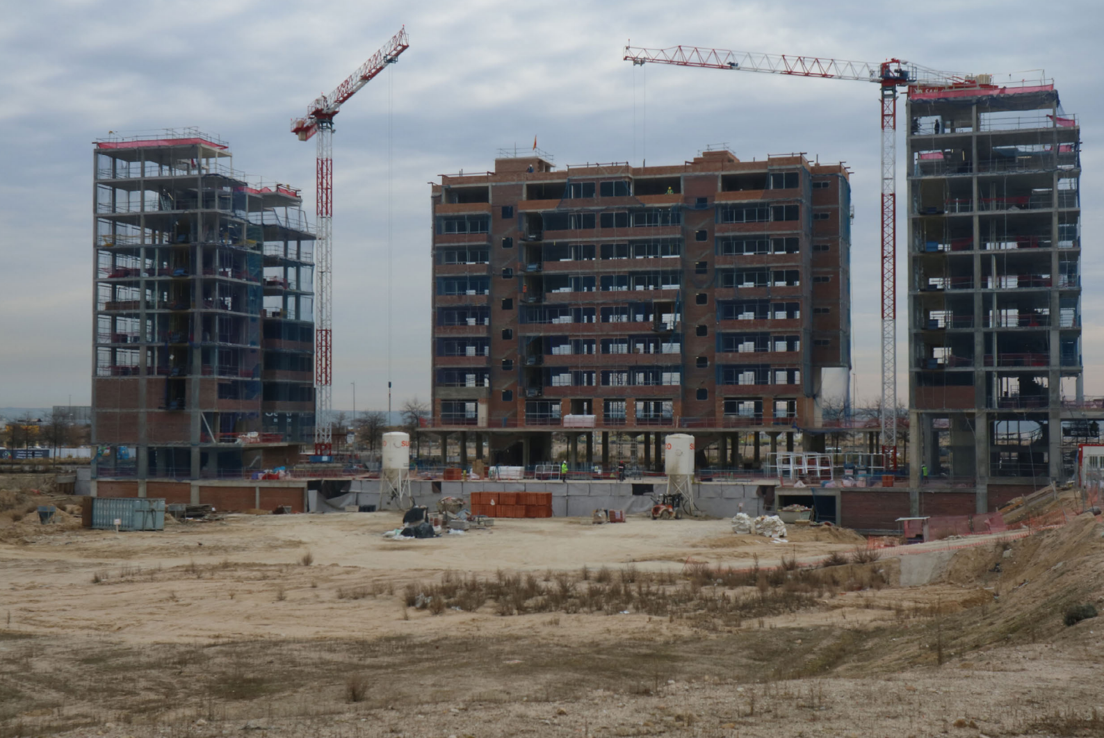
Obras de construcción de edificaciones para viviendas.
