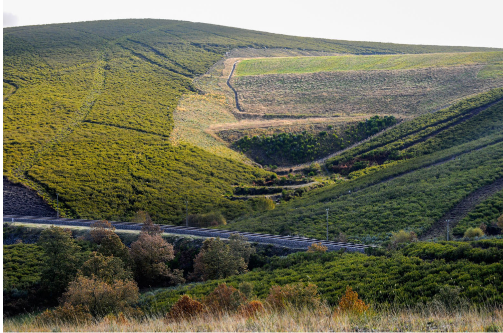
Zonas de hierba tratadas con tecnosoles en el vertedero de A Gudiña.
