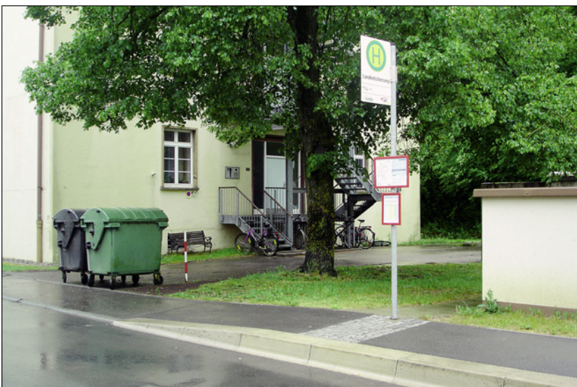
Parada de autobús en calle sin diferenciación de altura acera-calzada. Tübinga (Alemania).
