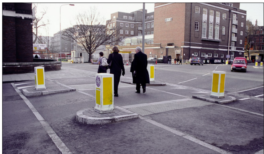
Refugio peatonal sin paso de cebra pero con lomo. Londres.
