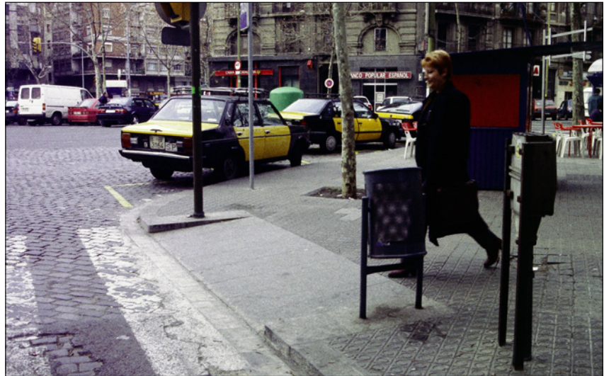
Rebaje de bordillo en paso peatonal de Barcelona.
