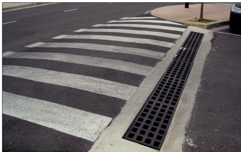
Canalización del agua en lomo.
