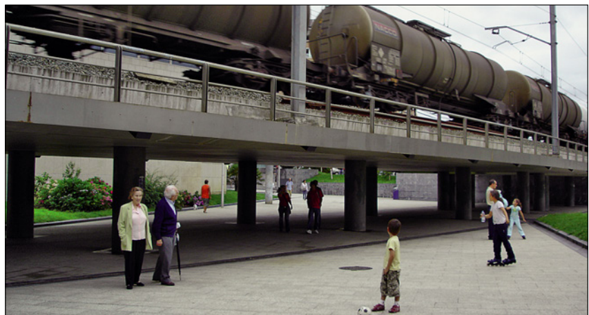
Paso inferior bajo las vías del ferrocarril. Amplitud, visibilidad, transparencia como requisitos de la seguridad. San Sebastián.
