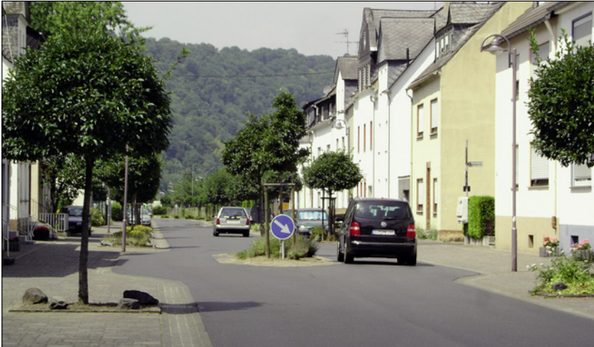
Estrechamiento central mediante isleta. Alemania.
