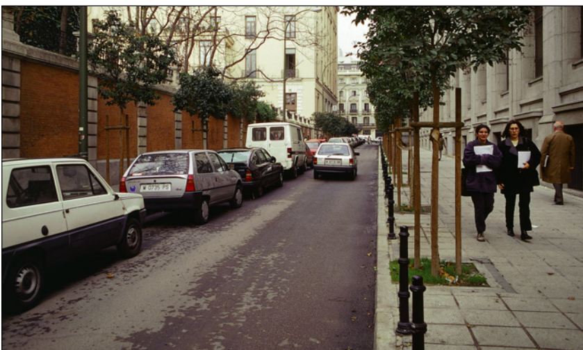
Ampliación de acera por supresión de una de las dos bandas de aparcamiento. Madrid.
