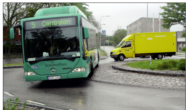
Glorieta con espacio montable para autobuses y vehículos pesados. Lund (Suecia).
