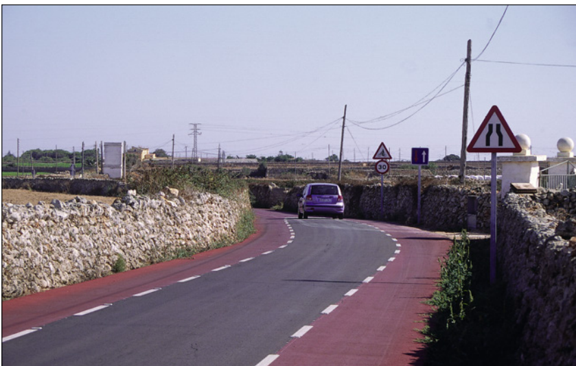
Carretera con carril central único para los dos sentidos de circulación y arcenes para los modos no motorizados. Menorca.
