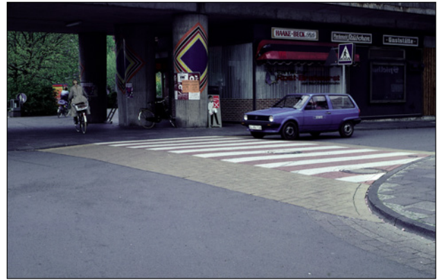
Paso de cebra sobreelevado.
