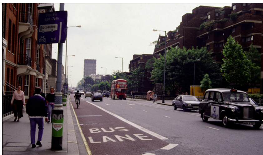
Carril bus diferenciado de la calzada por el color del pavimento. Londres.
