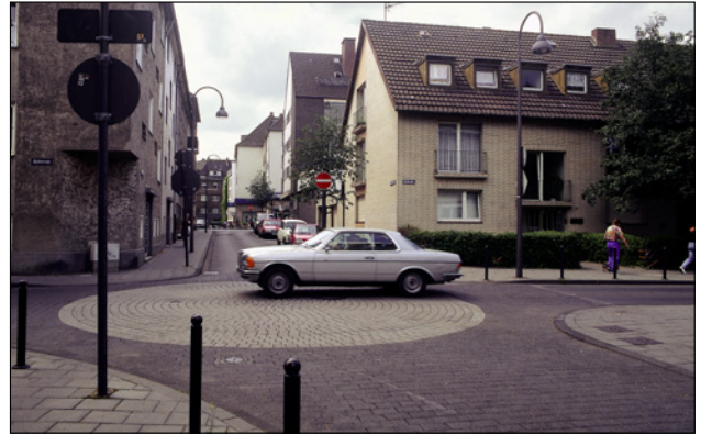
Meseta circular en intersección en Colonia (Alemania).
