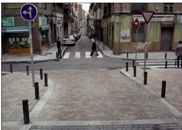
Paso peatonal indicado mediante pavimentación. Madrid. Nueva. H-
