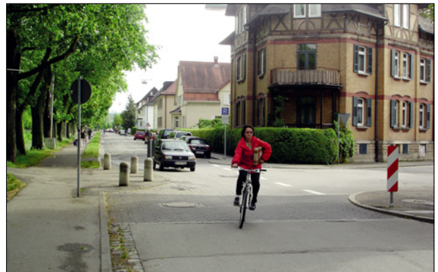
Desvío de trayectoria en intersección en T. Tubinga (Alemania).
