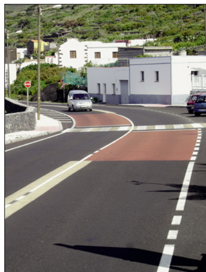
Tratamiento de travesía en un núcleo rural en El Hierro.
