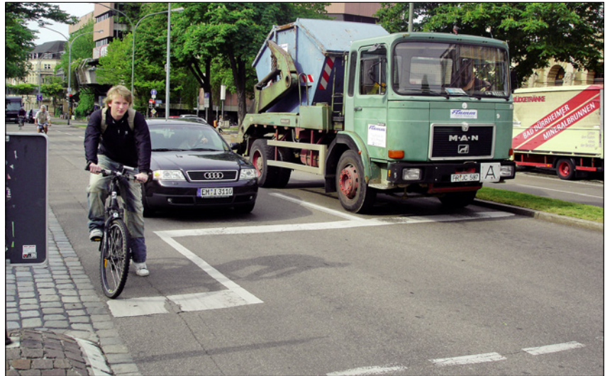
Retranqueo de la línea de detención diferenciado para vehículos y ciclistas en un semáforo. Friburgo (Alemania).
