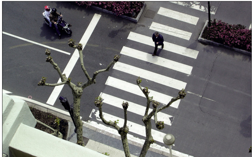
Retranqueo amplio de la línea de detención de los vehículos ante el paso de peatones. San Sebastián.
