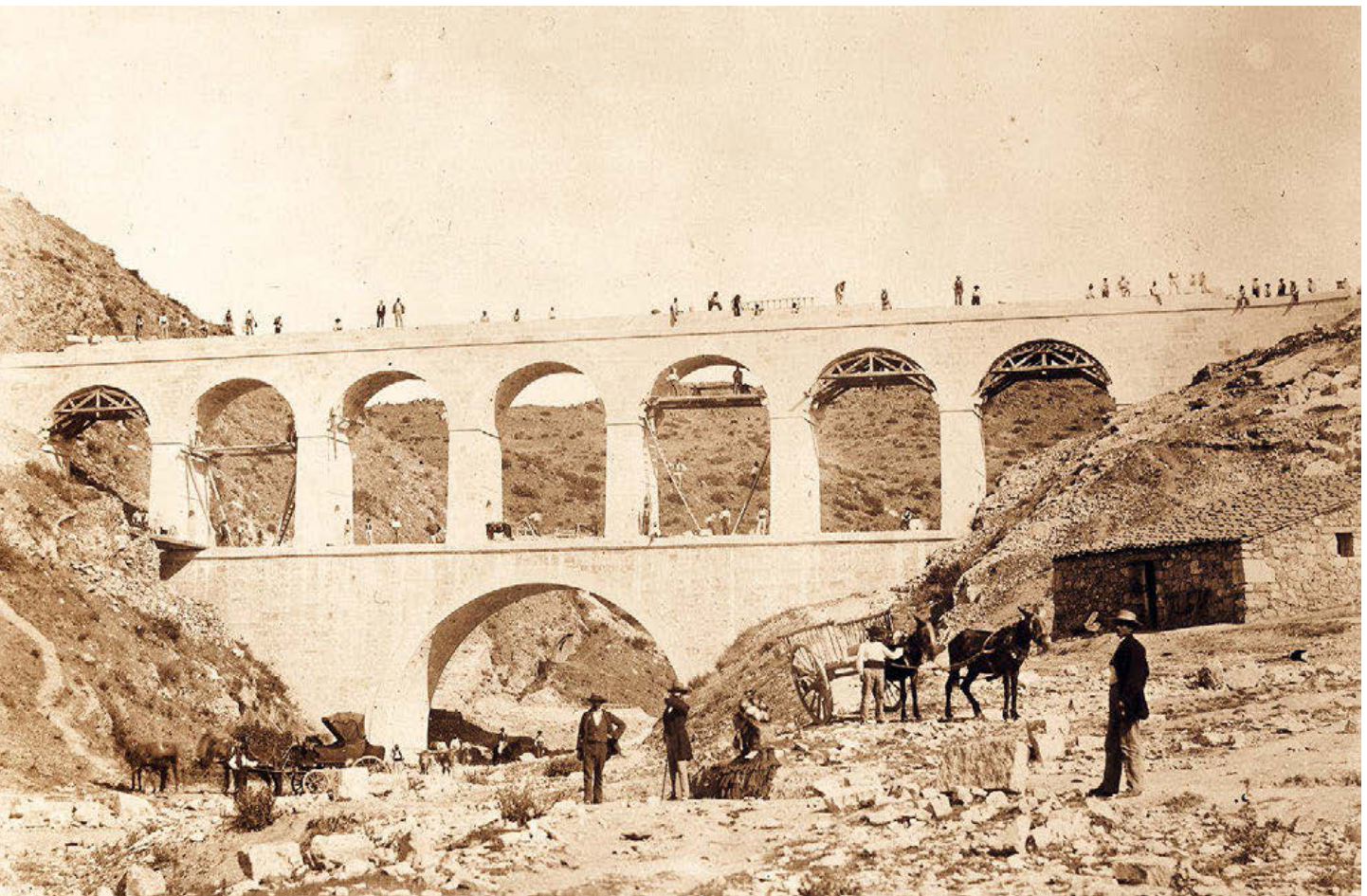
Acueducto de la Sima. Fotografía de Charles Clifford, 1858. Archivo fotográfico del Canal de Isabel II.
