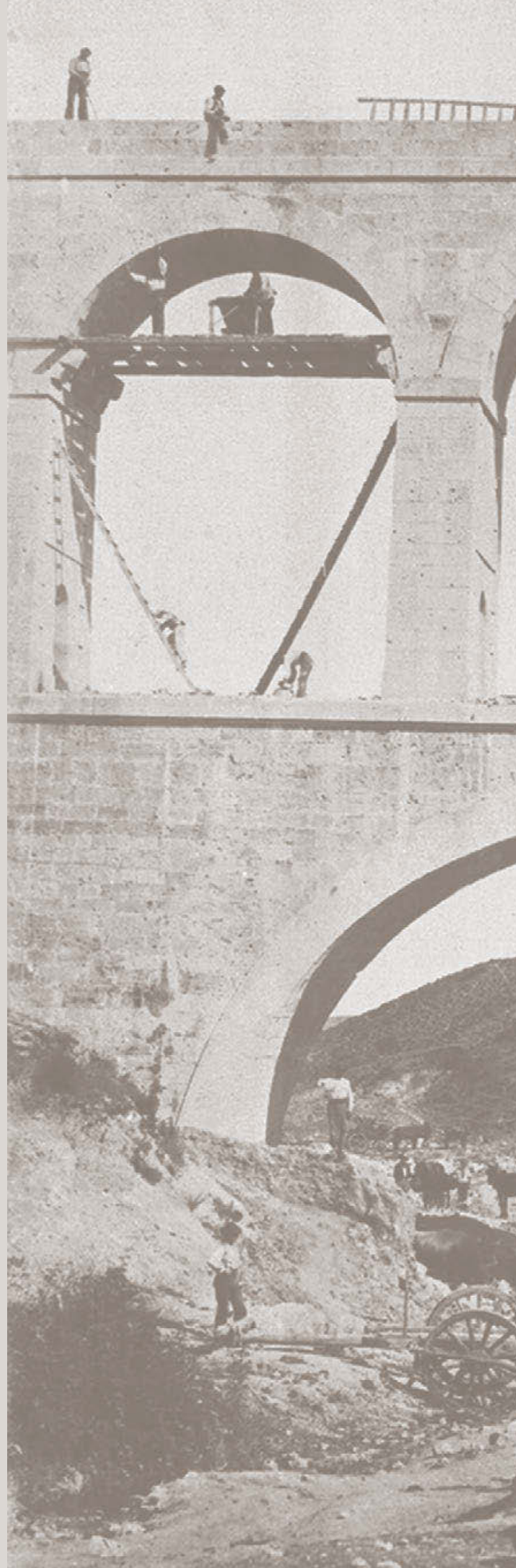
Acueducto La Sima (detalle). Fotografía de Charles Clifford. 1858. Colección particular.
