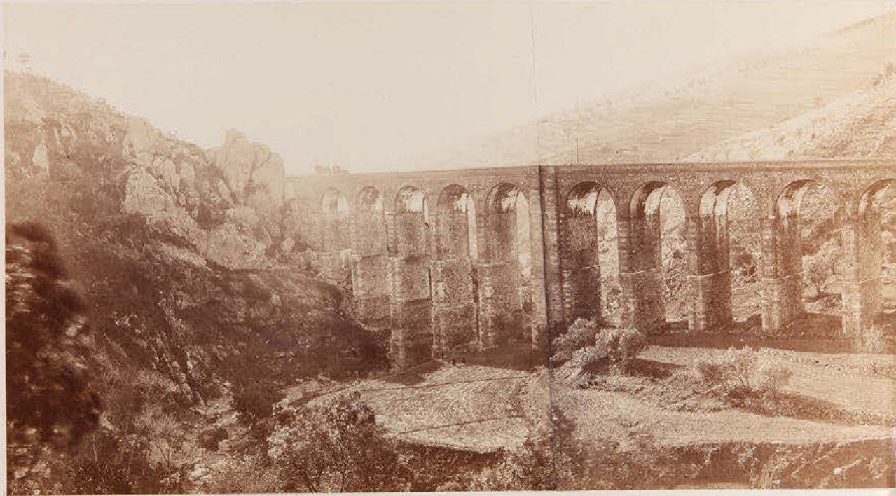
VIADUCTO DE ferrocarril de Zar PROVINCIA DE
