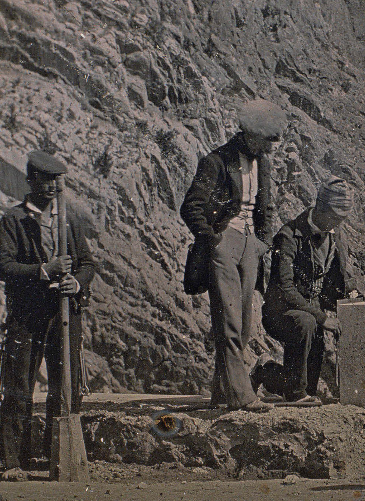
Presos trabajando en la carretera de Las Cabrillas (detalle: Ingeniero observando los trabajos). Daguerrotipo anónimo, ca. 1850-1. Archivo Lucio del Valle.
