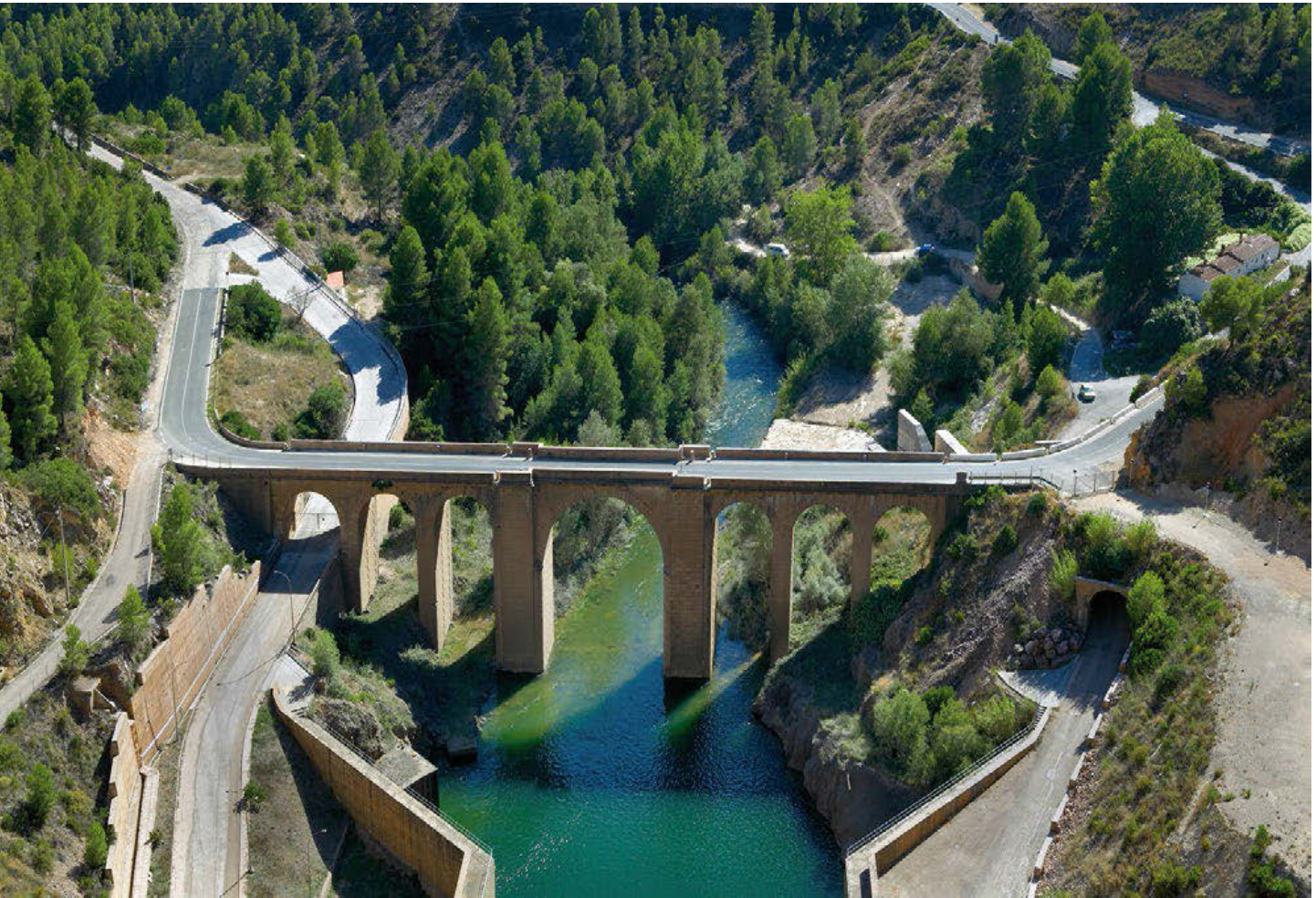
Puente de Contreras sobre el río Cabriel. Fondo CDR.
